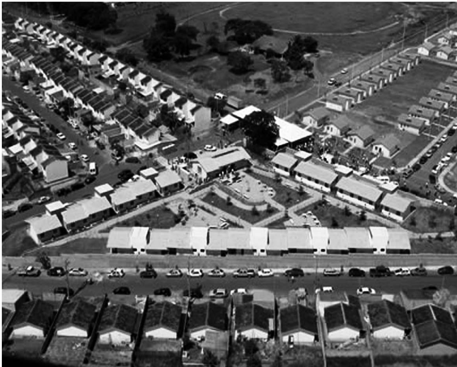
Imagem aérea de um dos condomínios para idosos, “Vila Dignidade”, construído na cidade de Avare
