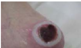
Consequência do excesso de umidade
