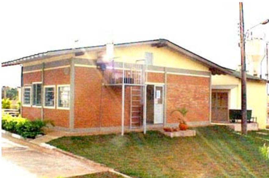
Figura II.7 - Laboratório de Resíduos Químicos – LRQ – Campus de São Carlos (SESMT, 1999).
