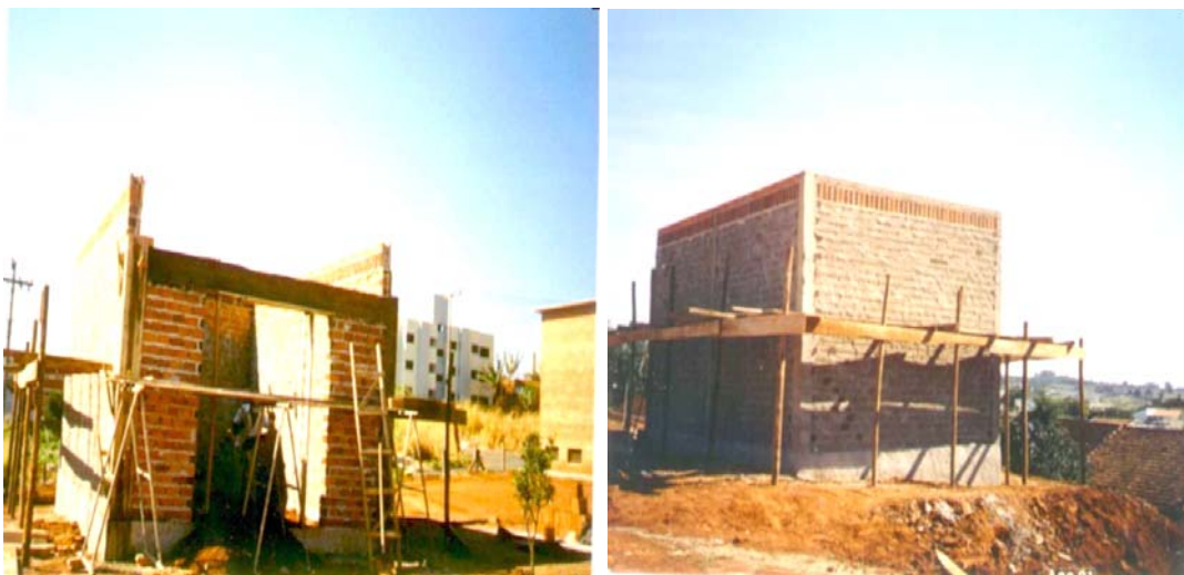
Figura II.6 – Etapas da Construção do Entreposto de Resíduos (PCASC, 1989).
