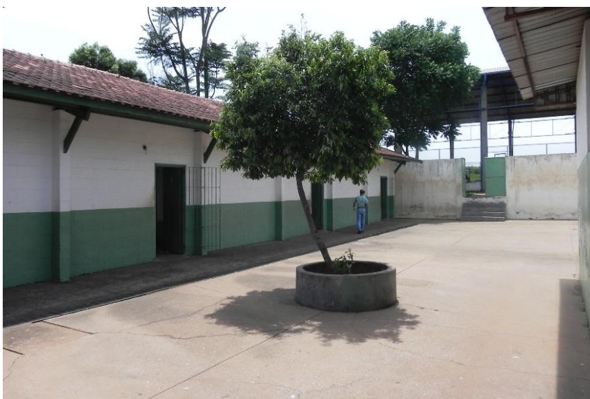
Foto 4: Entrada para salas de aula e quadra poliesportiva ao fundo.
