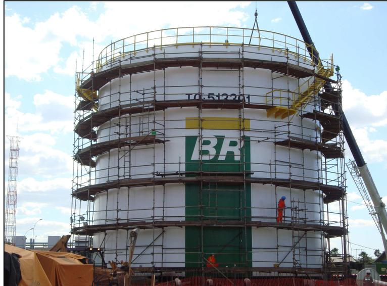
**FIGURA 27:** Tanque de Armazenamento em Processo de Montagem.
