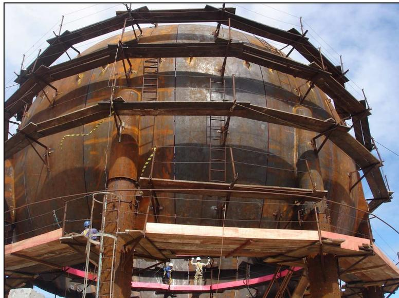
**FIGURA 28:** Esfera de Armazenamento em Processo de Montagem.
