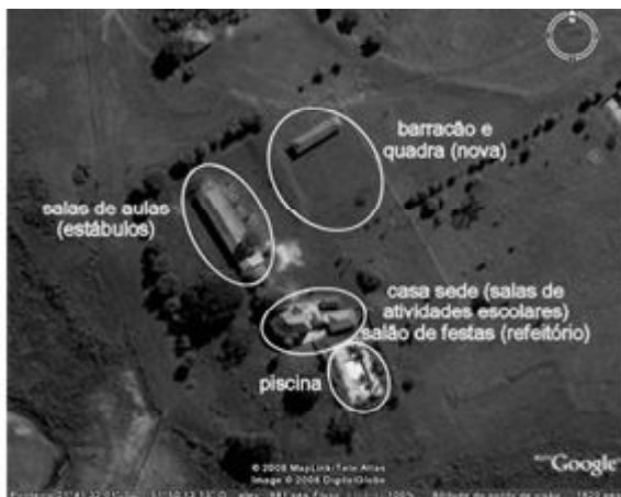
Figura 9 – Imagem de satélite identificando os elementos estruturais da área comunitária ( P.A. Primavera)
