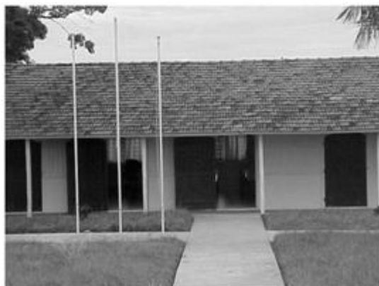
Figura 6 – Vista frontal das salas de aula (antigo estábulo) da Escola do P.A. Primavera Fonte: Acervo GEPEP.
