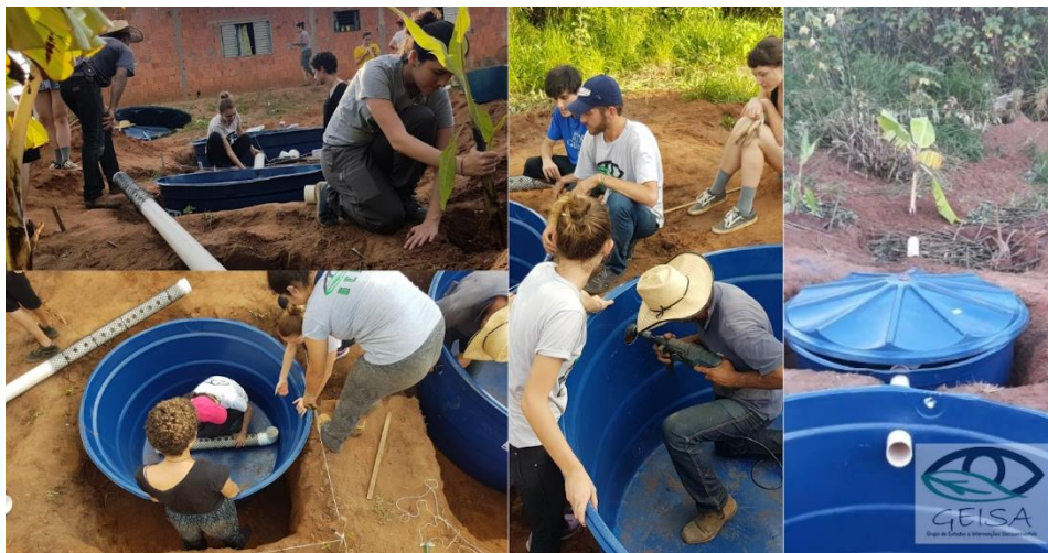
Figura 4 - Construção da tecnologia
