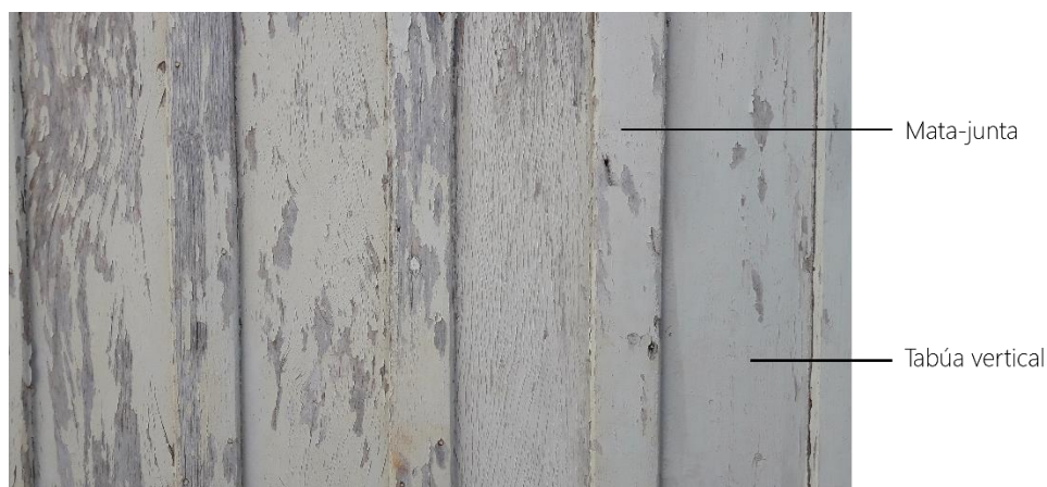
Figura 2 – detalhe do conjunto Mata-junto das paredes da sede do Assentamento Primavera
