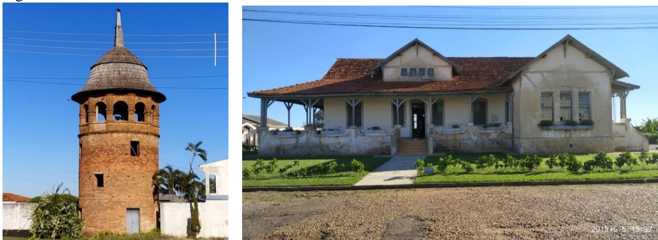
Figura 7 – Torre e fachada frontal do casarão sede da Santa Sofia
