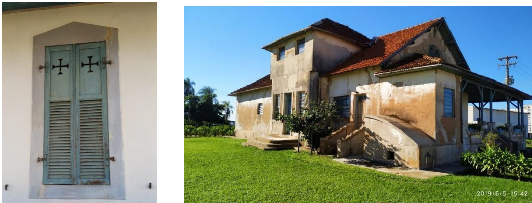
Figura 6 – Detalhes do casarão sede da Santa Sofia
