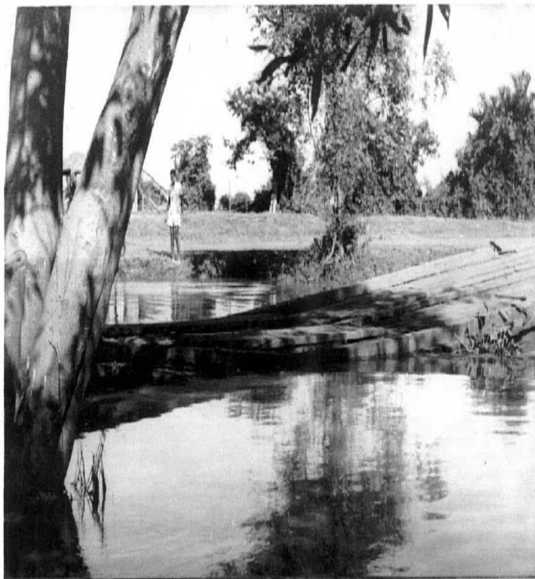
Ponte sobre o Ribeirão Ponte Pensa, durante a inundação. (Velha Rubinéia).
