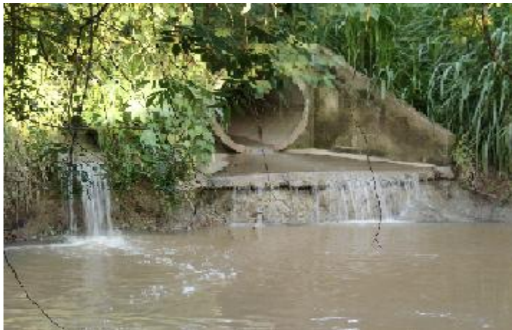
Figura 12a. O (P3) localiza-se a jusante da Estação de Tratamento de Água (ETA).
