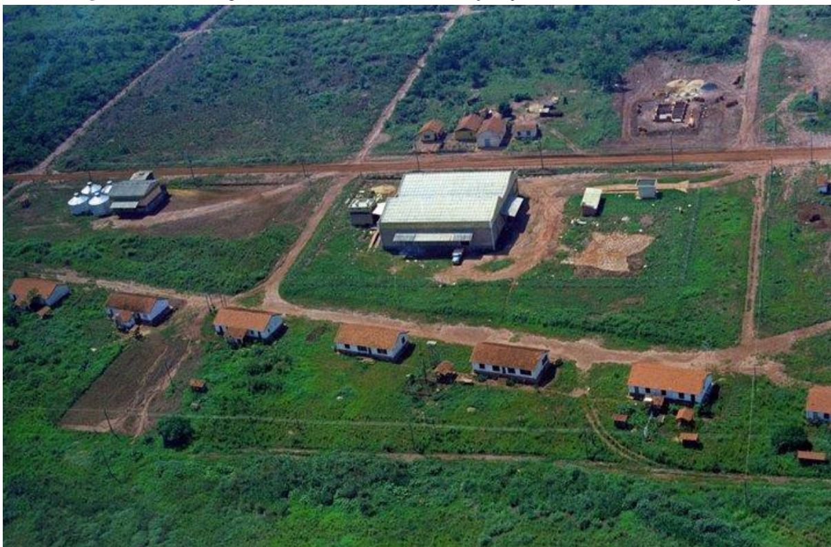
Figura 70 - Outro ângulo da foto aérea com as construções já existentes e as novas instalações
