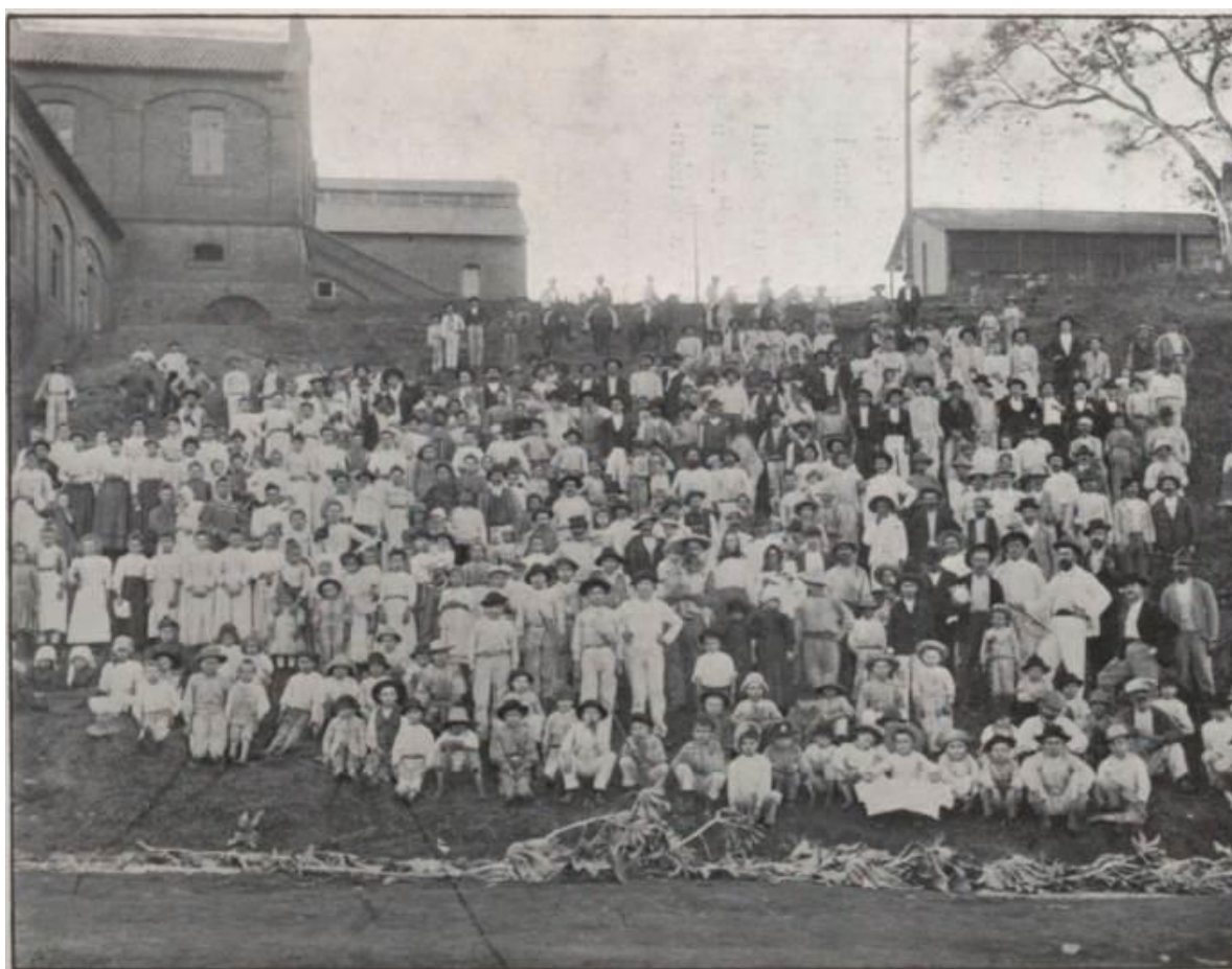
Figura 15 - Imigrantes japoneses e europeus ao lado da casa de beneficiamento de café em 1909
