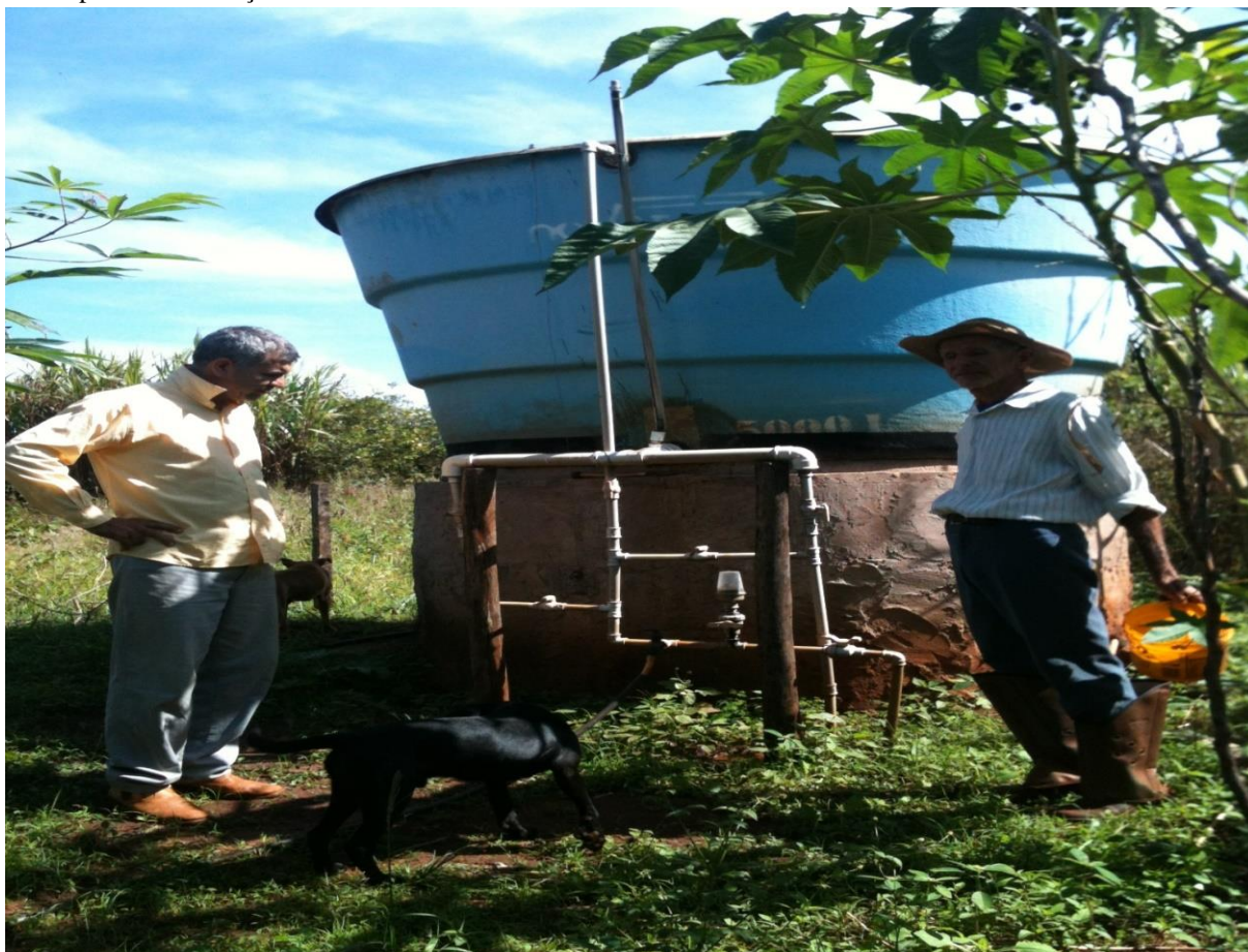
Figura 35 – Clorador Embrapa no PDS Santa Helena (instalação a partir de 2015 pela parceria ENACTUS e Embrapa Instrumentação nos lotes
