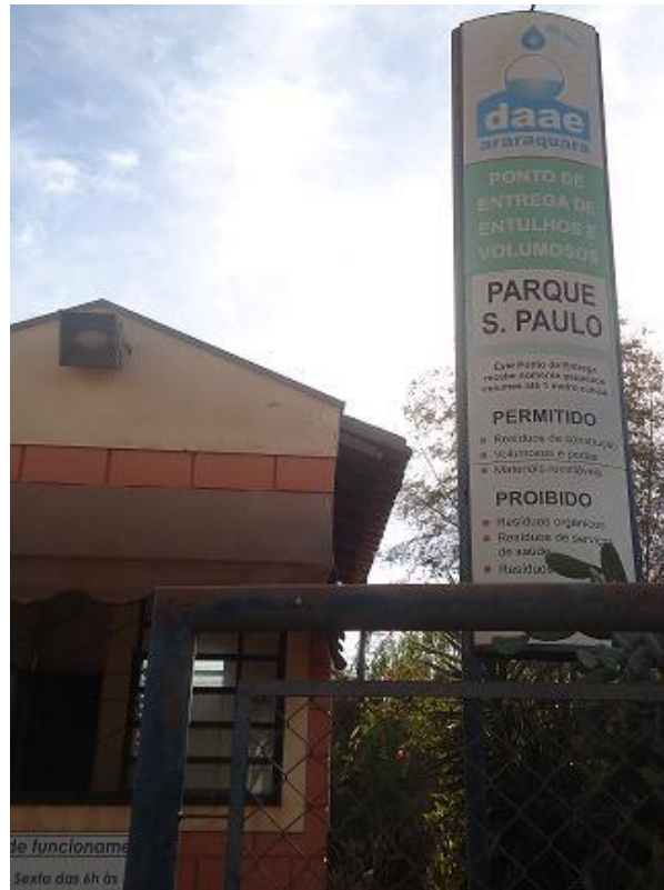
Figura 17 – Ponto de Entrega de Entulhos e Volumosos (PEV) – Rua Maria Brambilla, 384
