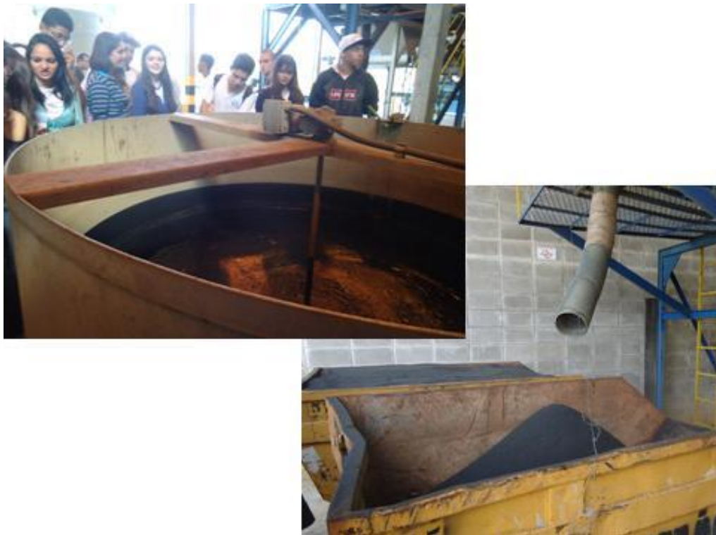
Figura 49 – Visita à ETE – Estação de Tratamento de Esgotos – Tratamento do lodo
