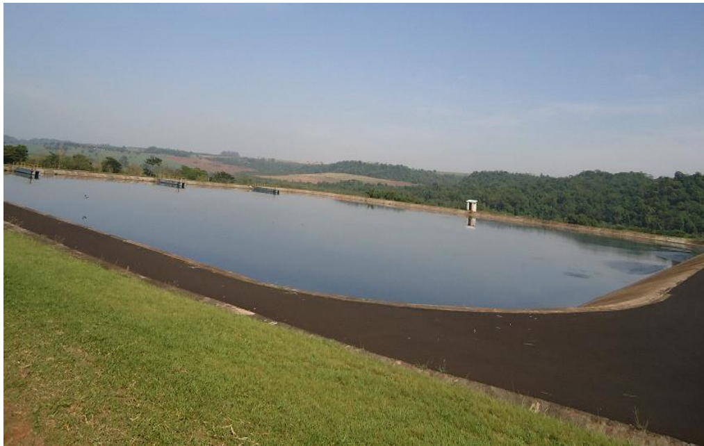
Figura 48 – Visita à ETE – Estação de Tratamento de Esgotos – Lagoa de Sedimentação
