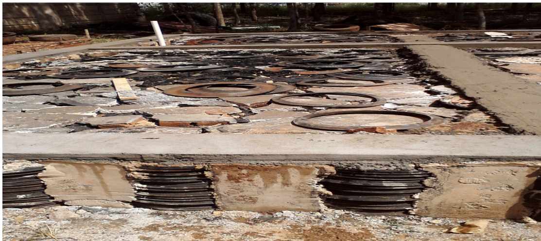
Figura 7. RCC em pedaços ou moídos sobre o piso
