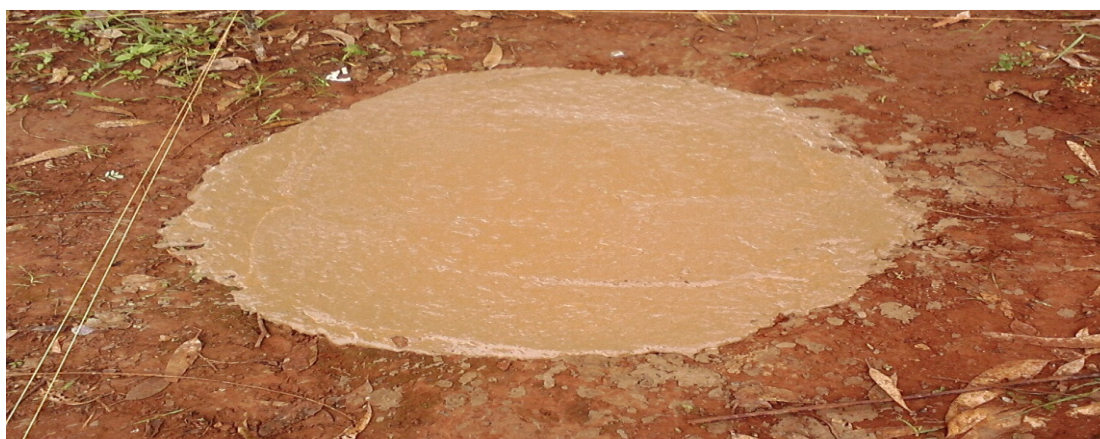
Figura 4. Estaca encoberta com massa de cimento e RCC moído
