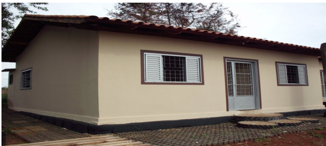
Figura 17. Casa construída com pneus inservíveis apresentada na entrevista
