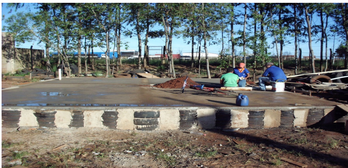
Figura 8. Cobertura de massa de cimento e RCC moído ou triturado sobre o piso
