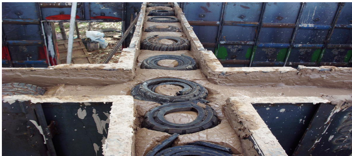
Figura 12. Preenchimento do molde com tijolos de pneus, fragmentos de RCC e massa
