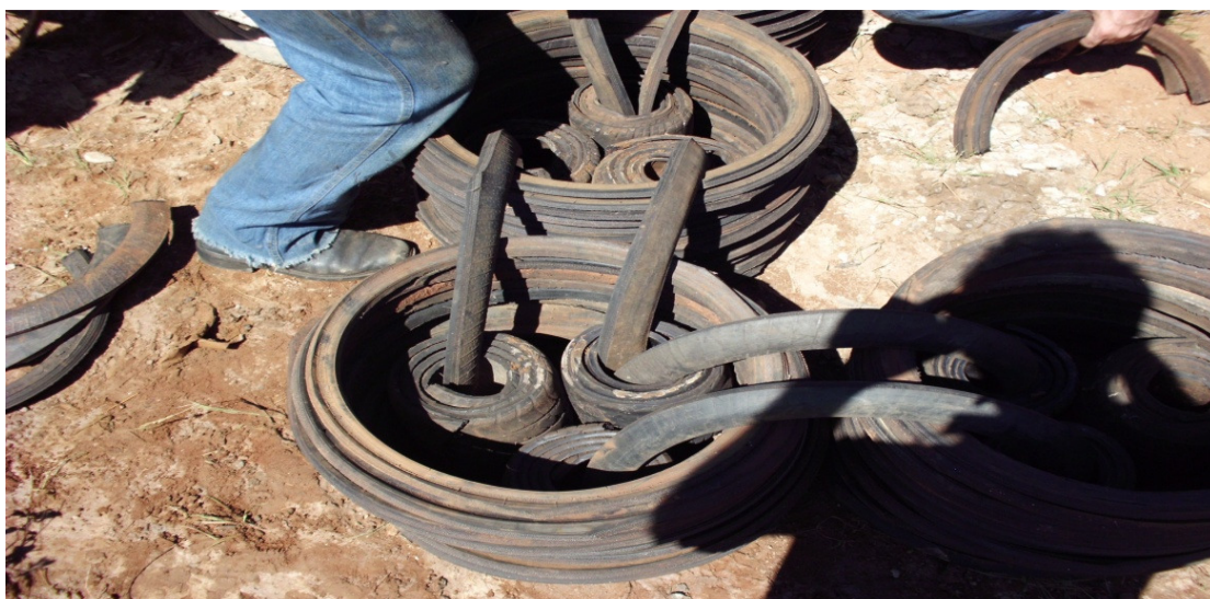
Figura 6. Travamento das colunas com talões de pneus cortados
