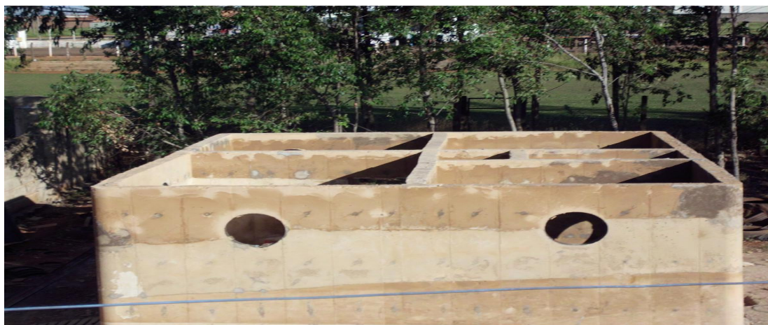
Figura 15. Visão superior das paredes após a desmontagem total do molde
