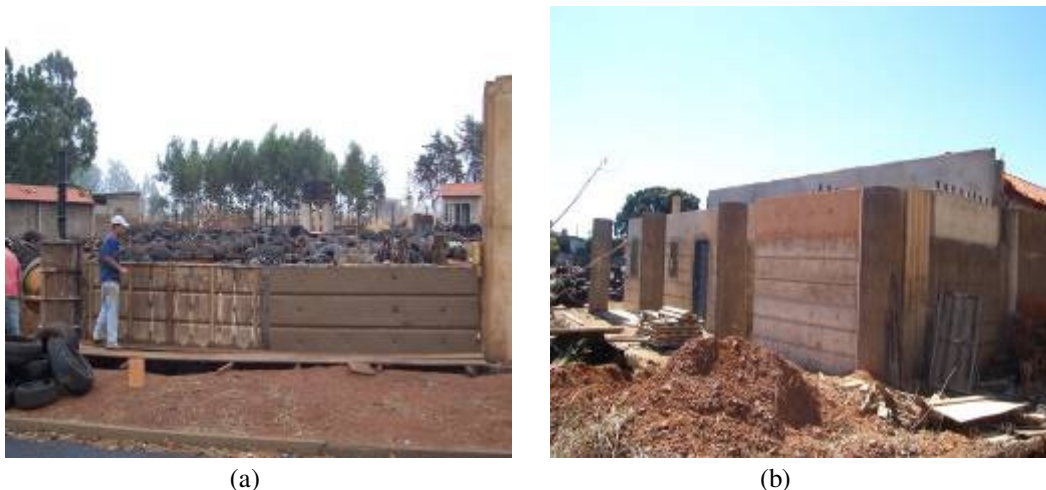
Figura 10 (a e b) – Execução dos painéis de paredes em concreto com entulho de demolição, fragmentos de borracha de pneus, garrafa PET e vidros.
