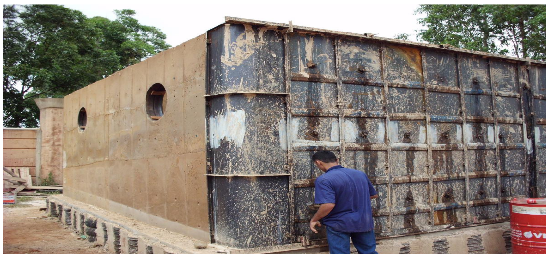
Figura 13. Visão externa da parede após a desmontagem parcial do molde
