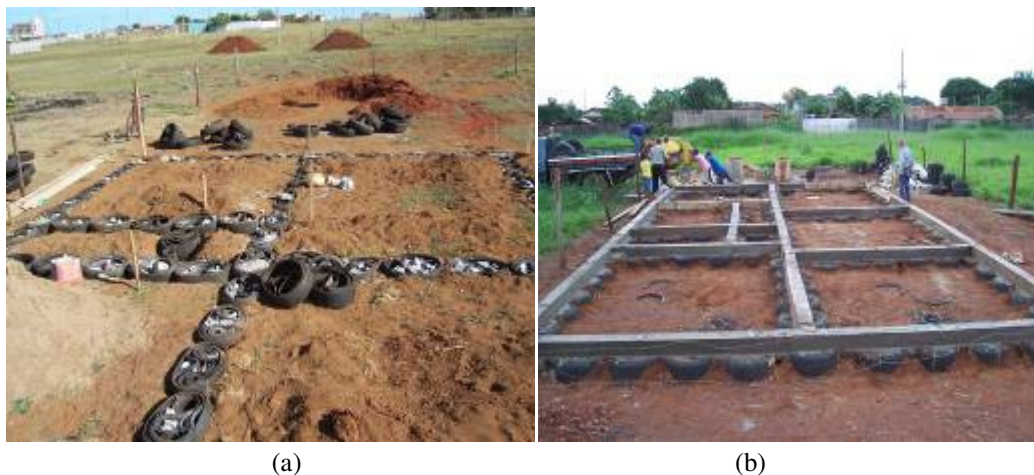
Figura 8(a e b) – Execução da fundação para habitações térreas.
