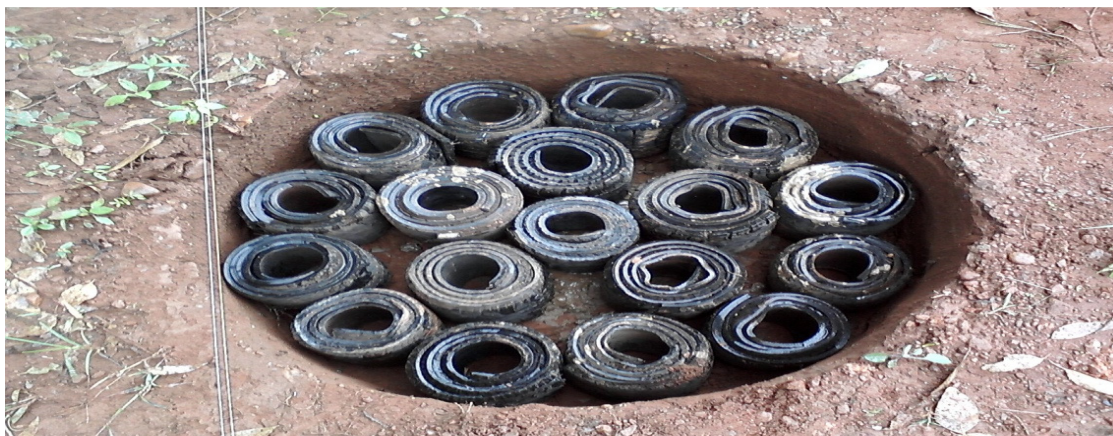
Figura 3. Estaca preenchida com tijolos de pneus
