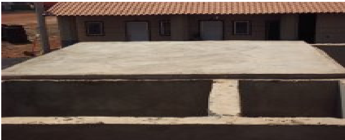
Figura 16. Laje edificada com massa de cimento e RCC moído sobre talões de pneus
