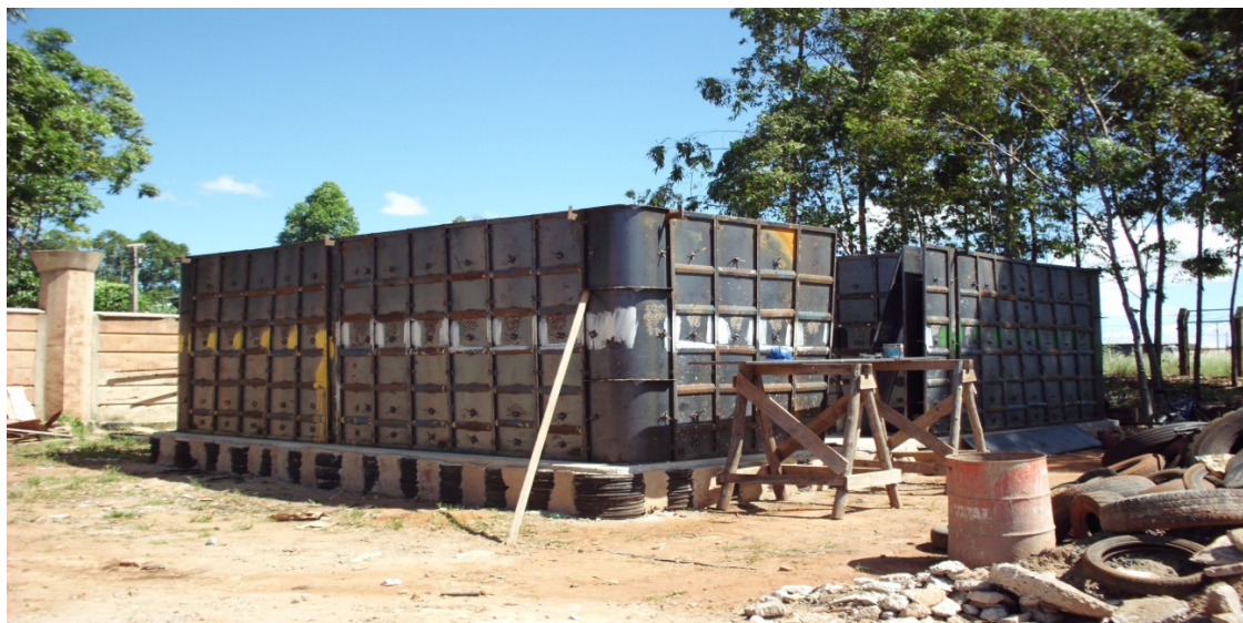
Figura 9. Visão externa do molde após a montagem
