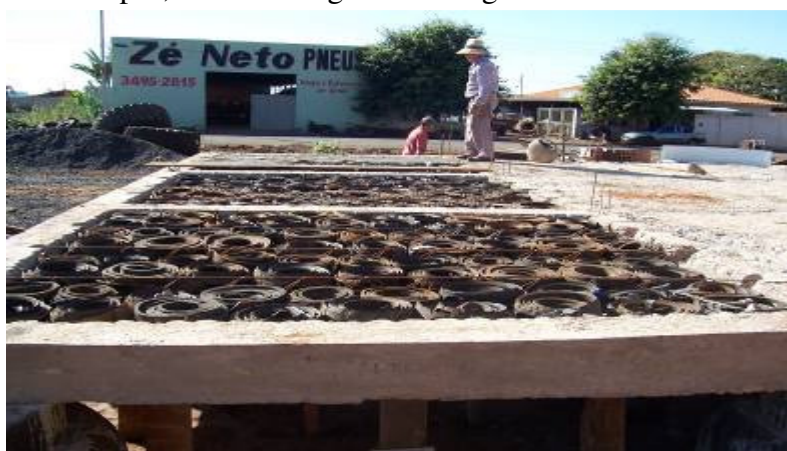
Figura 11 – Preparo da laje de forro para concretagem.
