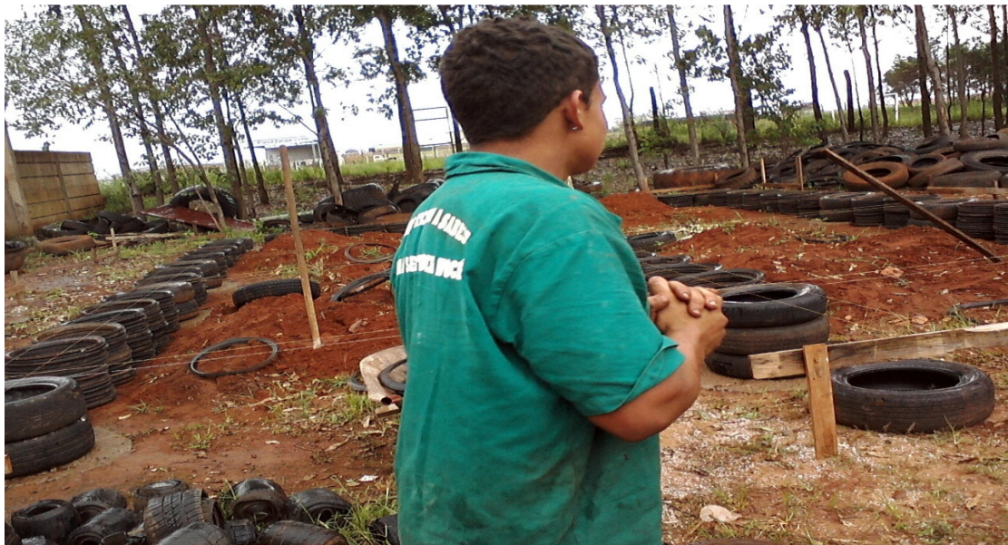
Figura 5. Construção da viga baldrame com talões de pneus
