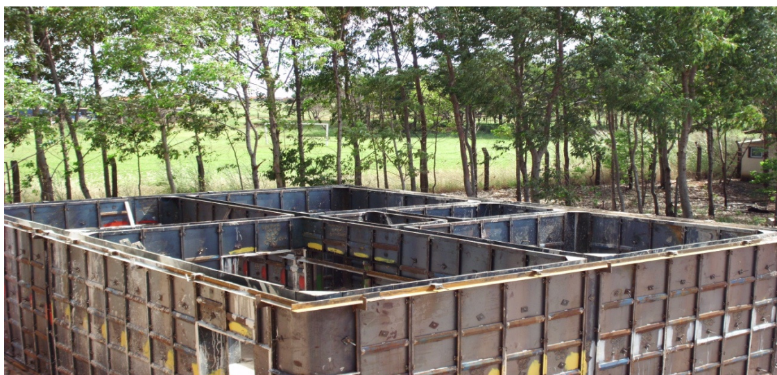
Figura 10. Visão superior do molde após a montagem
