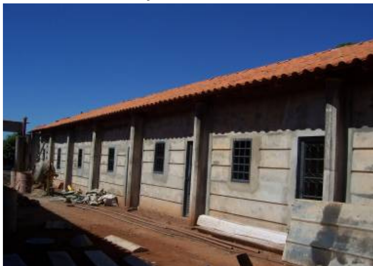
Figura 12 – Telhado com telha plan o protótipo avaliado em Goiatuba.
