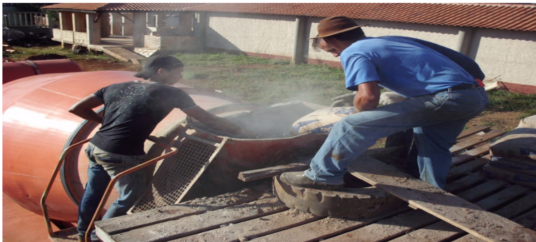
Figura 11. Feitura da massa em caminhão betoneira
