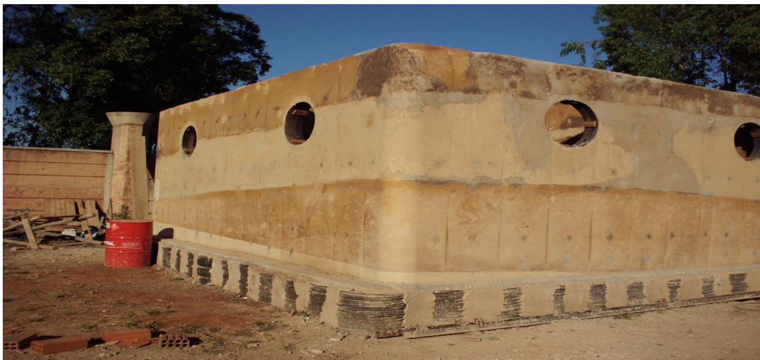
Figura 14. Visão externa das paredes após a desmontagem total do molde
