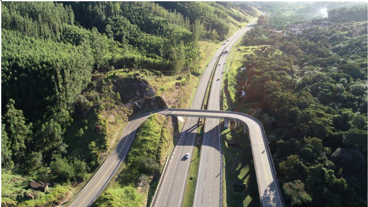
Figura 1: Rodovia Dom Gabriel P. B. Couto (SP 300), Km 90, principal acesso ao Bairro Pedregulho, nas proximidades da comunidade Pedreira. Trecho entre Itu e Cabreúva.
