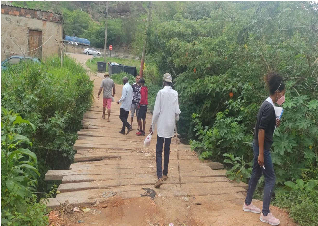
Figura 44: Antiga ponte de madeira, único acesso à vila. Foi reformada em 2022 pela própria comunidade e substituída por ponte de concreto.
