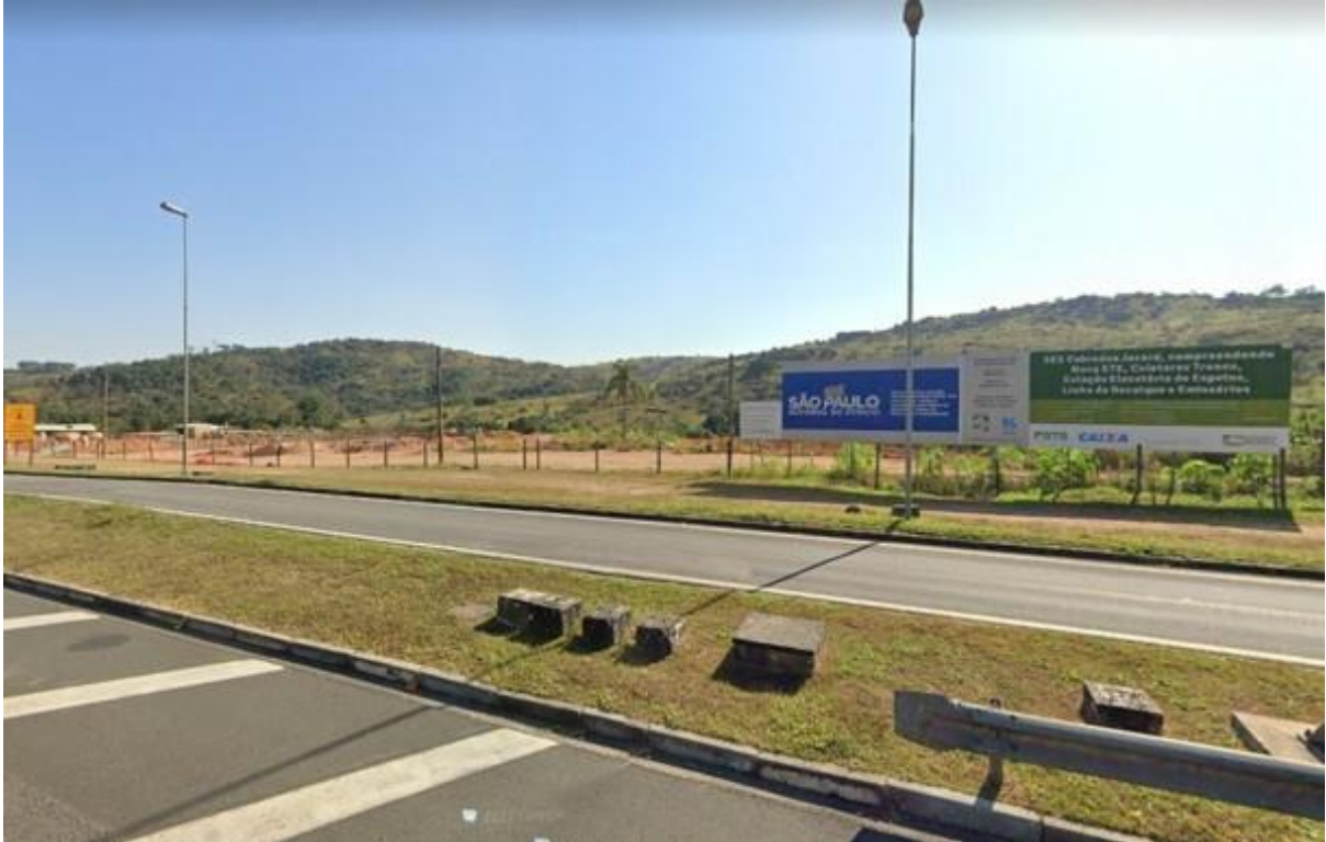
Figura 13: Obras de saneamento, nas margens do rio Pirai, em Cabreúva.
