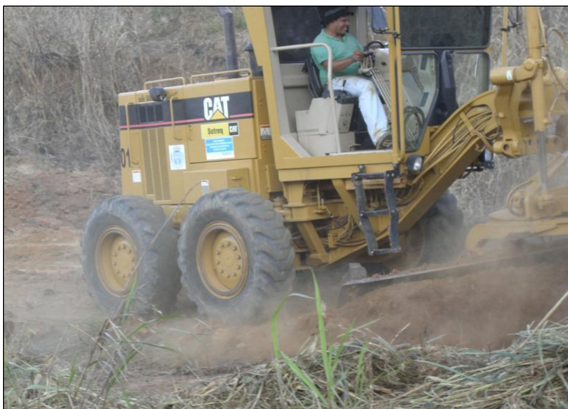
Figura 37 - Limpeza e preparação do terreno
