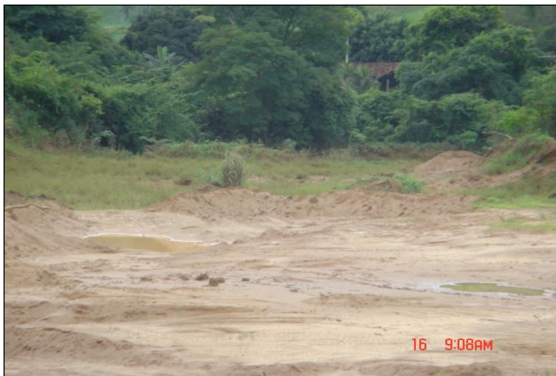
Figura 22 - Retirada da cobertura superficial da argila para produção de telhas e lajotas
