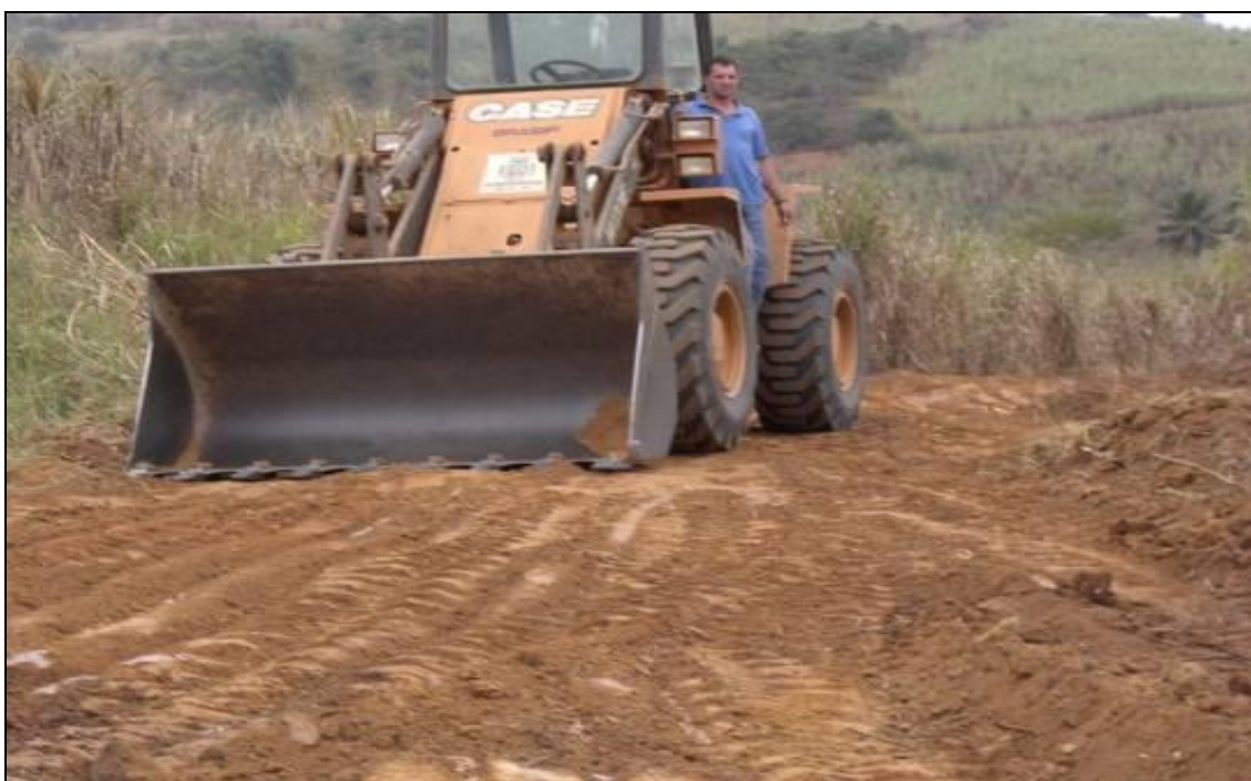
Figura 36 - Pá-carregadeira cedida pela Prefeitura Municipal de São Roque do Canaã, após a limpeza e quebra dos taludes
