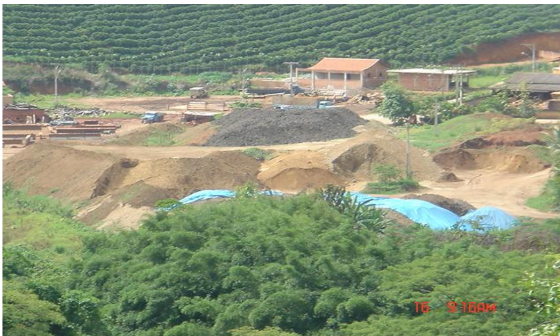
Figura 26 - Pátio da Cerâmica Arco-Íris em São Roque do Canaã, ES, sem apresentar nenhum cuidado quanto ao escoamento superficial
