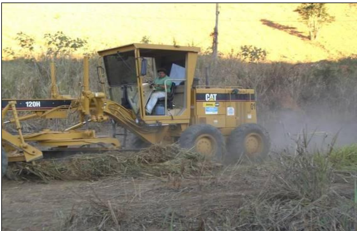
Figura 33 - Área sendo limpa e transformada pela Máquina Patrol cedida pela Prefeitura Municipal de São Roque do Canaã
