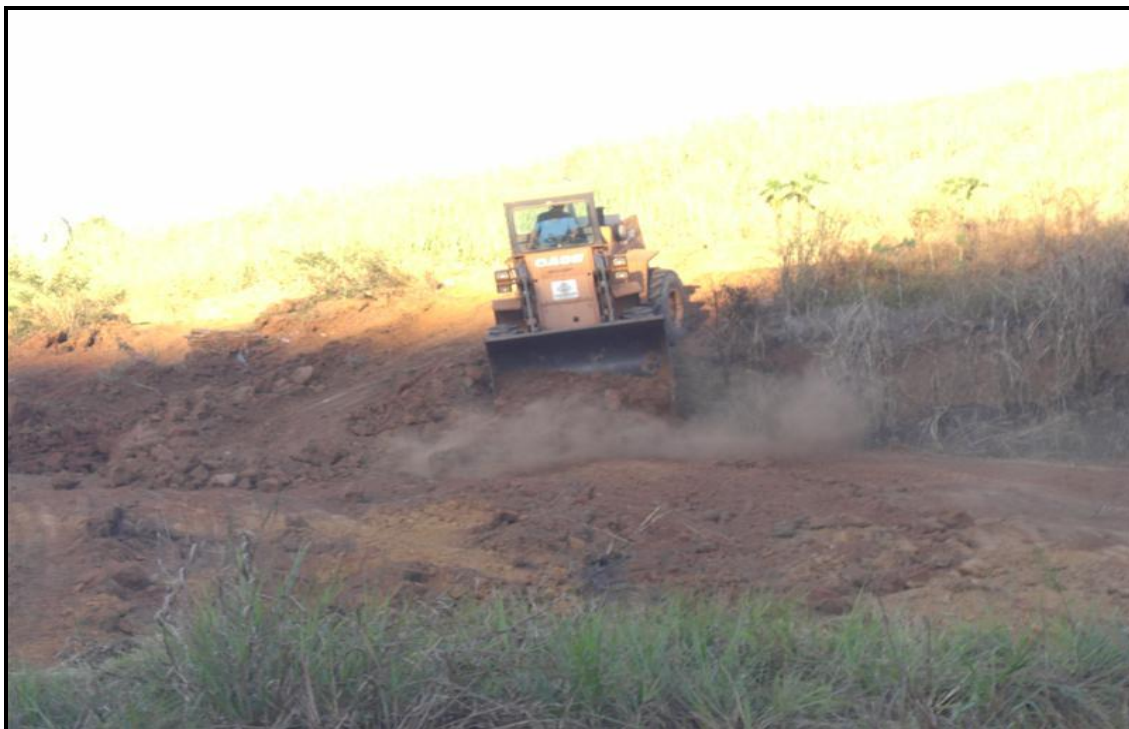
Figura 35 - Área sendo limpa e transformada pela máquina pá-carregadeira cedida pela Prefeitura Municipal de São Roque do Canaã
