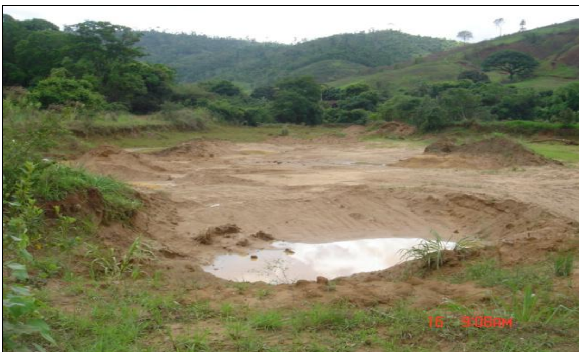
Figura 24 - Vista da estrada principal do impacto visual com erosão acelerada na zona rural do município de São Roque do Canaã
