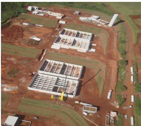
Foto 8 : Estação de Tratamento de Esgoto de São Carlos - em construção
