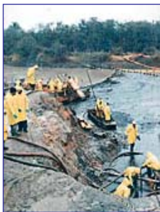
FOTO 03 : DETALHE DO TRABALHO DE LIMPEZA FONTE : AMBICENTER
