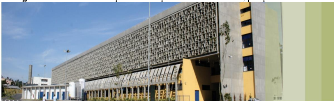
Figura 8 - Fachada do Hospital Municipal Cidade Tiradentes, perspectiva interna.
