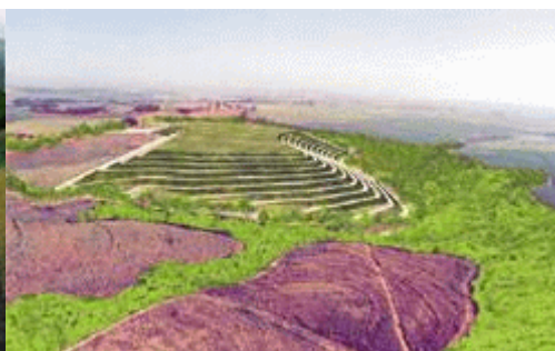
Aterro Industrial de Paulínia (SP)
