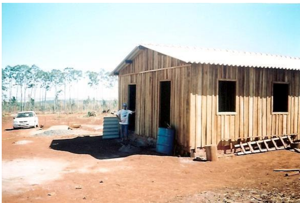
Figura 33: Casa construída com recursos do “Projeto Social” no assentamento Boa Sorte
