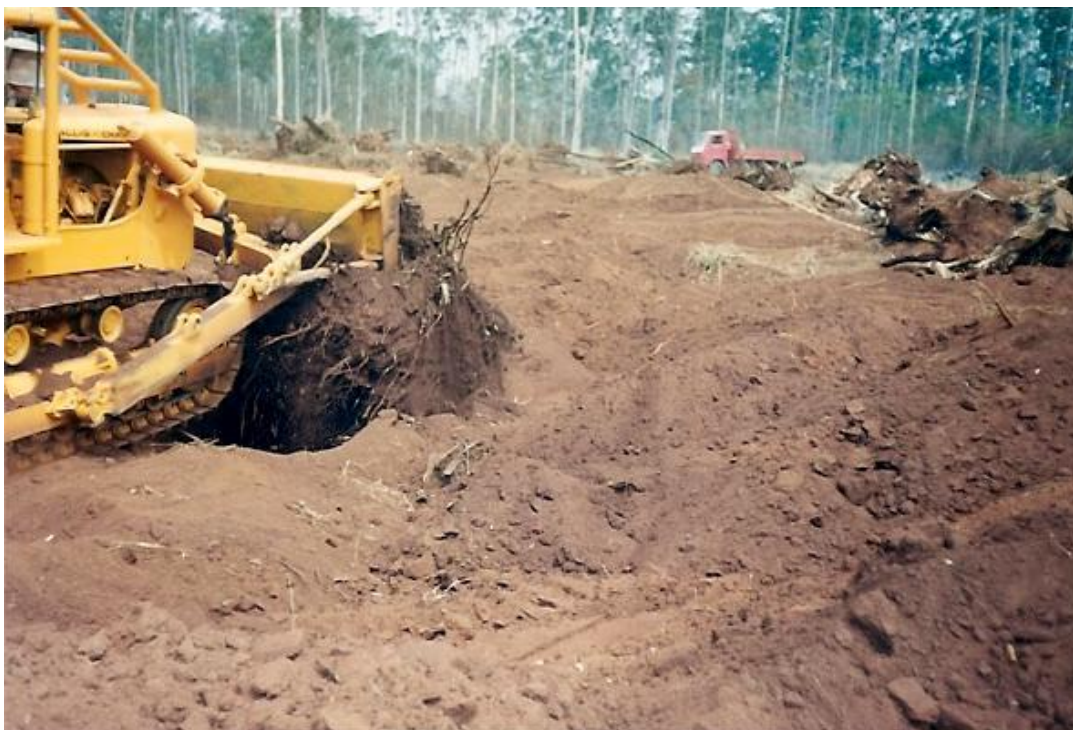
Figura 20: Aspecto da operação de destoca no assentamento Boa Sorte
