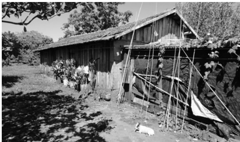
Figura 5 – Exemplar de moradia de madeira e lona no Assentamento Estrela da Ilha, 2012.
