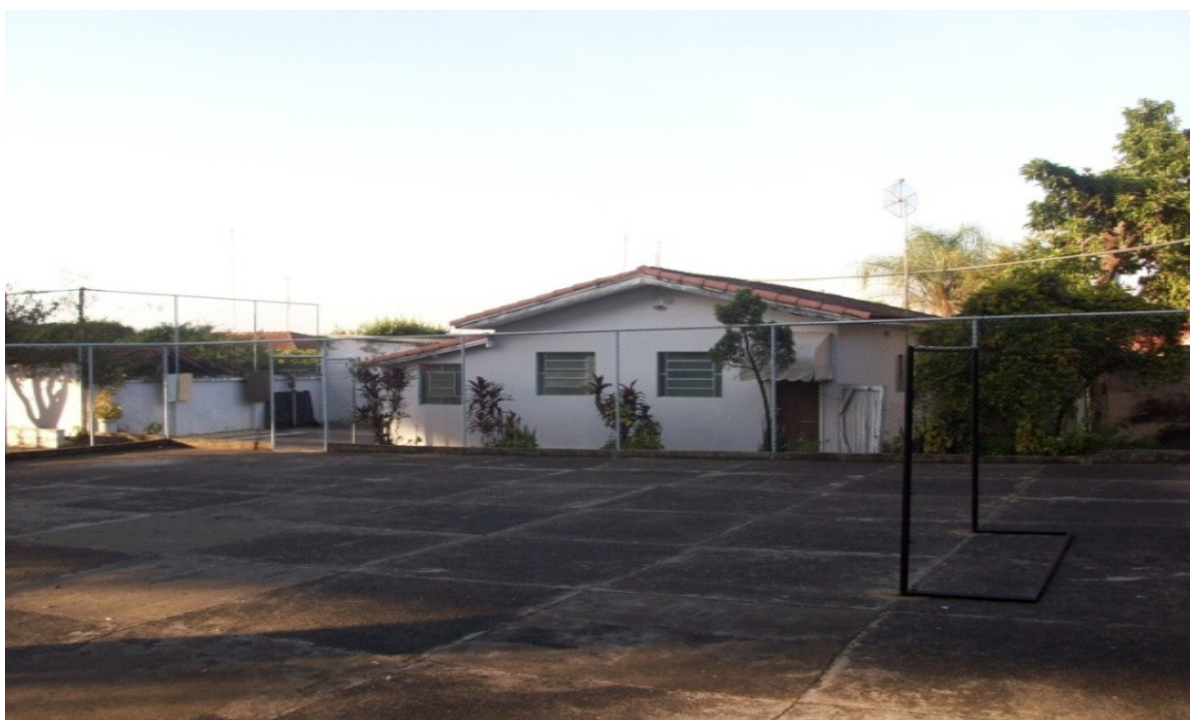
FIGURA 26: Espaço para brincadeiras da Escola Octacílio de O. Ramos Fonte: Pesquisa de Campo, 2009.
