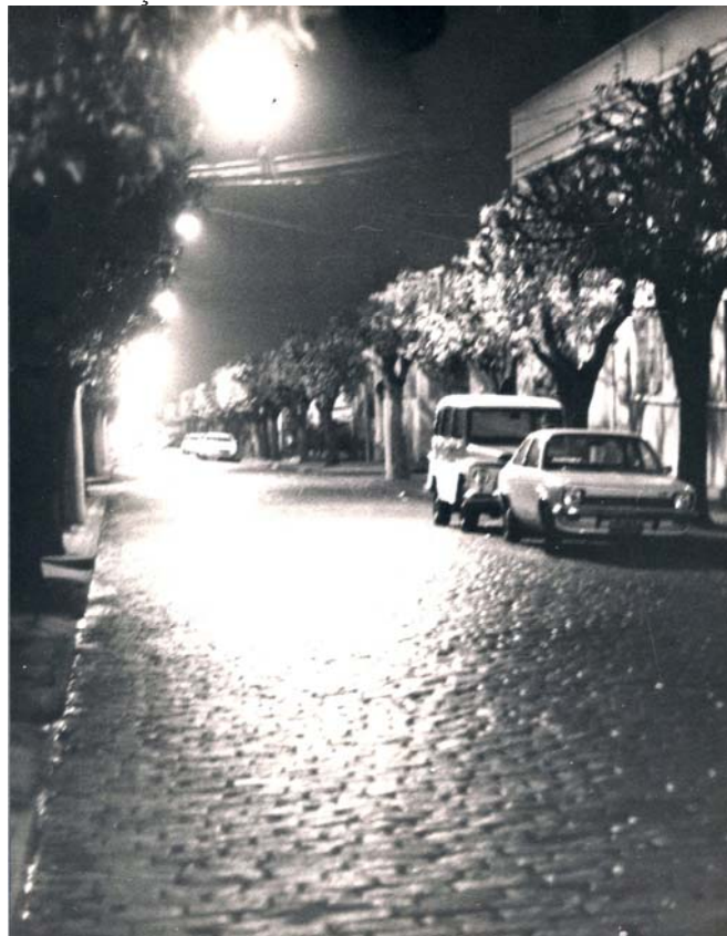
Figura 7: Vista da Rua Voluntários da Pátria, antes da revitalização.
