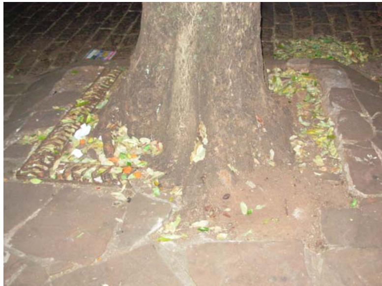
Figura 18: Licania tomentosa (oiti) demonstrando a exposição de raiz com a destruição da calçada no trecho viário Boulevard dos Oitis na Rua Voluntários da Pátria na cidade de Araraquara – SP
