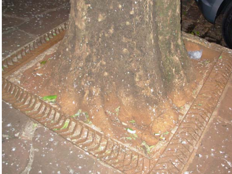
Figura 17: Licania tomentosa (oiti) demonstrando a exposição de raiz sem a destruição da calçada no trecho viário Boulevard dos Oitis na Rua Voluntários da Pátria na cidade de Araraquara – SP
