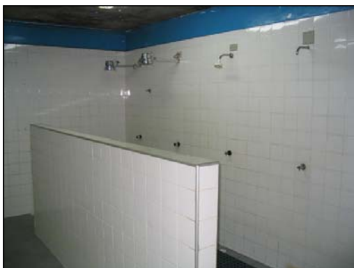
Fig. 58 – Vestiários – Chuveiros Fonte: O autor, 2004
