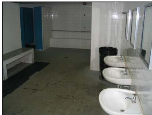
Fig. 59 – Vestiário - pias e sanitários Fonte: O autor, 2004
