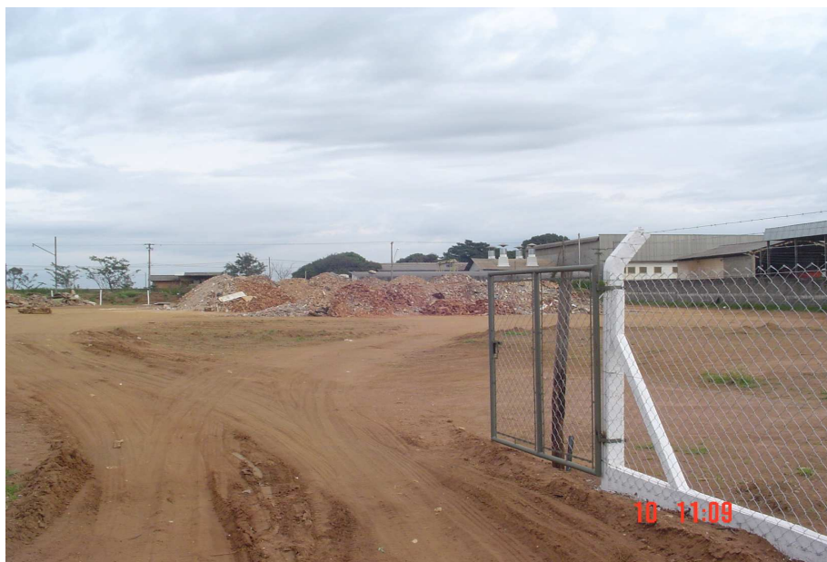
Figura 13c – Usina de Reciclagem
