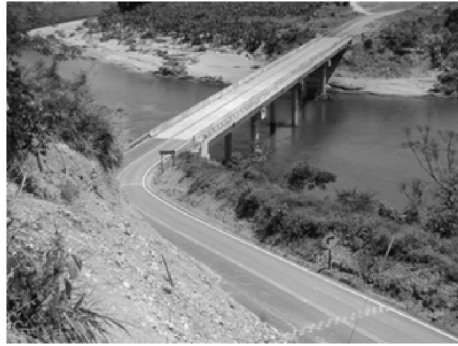
Figura 31 – Ponte de acesso a Comunidade de Ivaporunduva e São Pedro. Fonte: Trabalho de campo, 2011.
