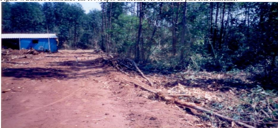
Figura 4. Barraco construído em 1997, após um hectare ser destocado para esta finalidade.
