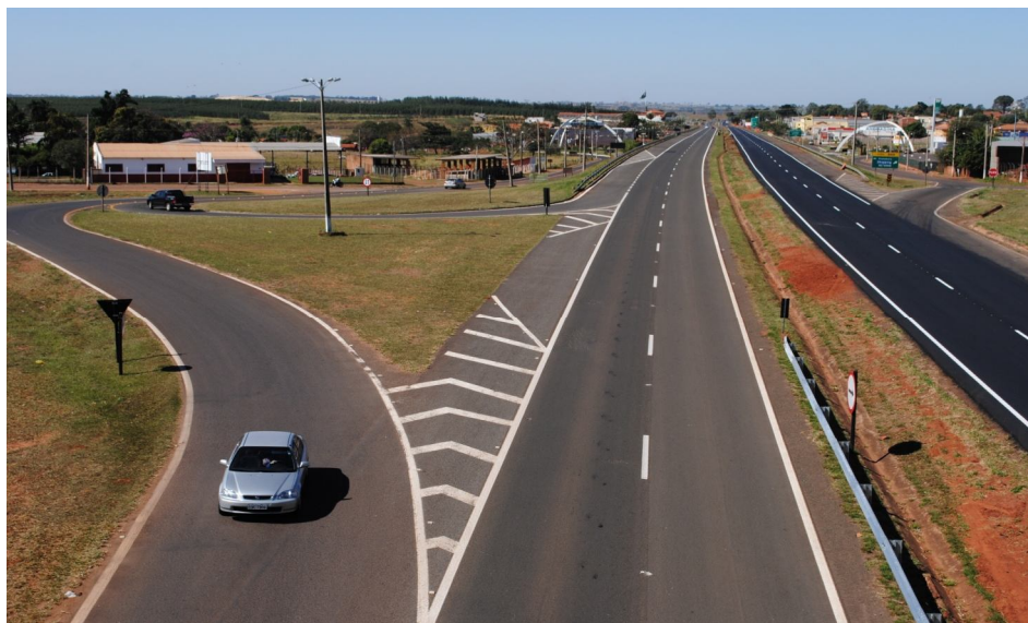
Figura 4 – Foto da Rodovia Marechal Rondon acesso a Andradina em 2012
