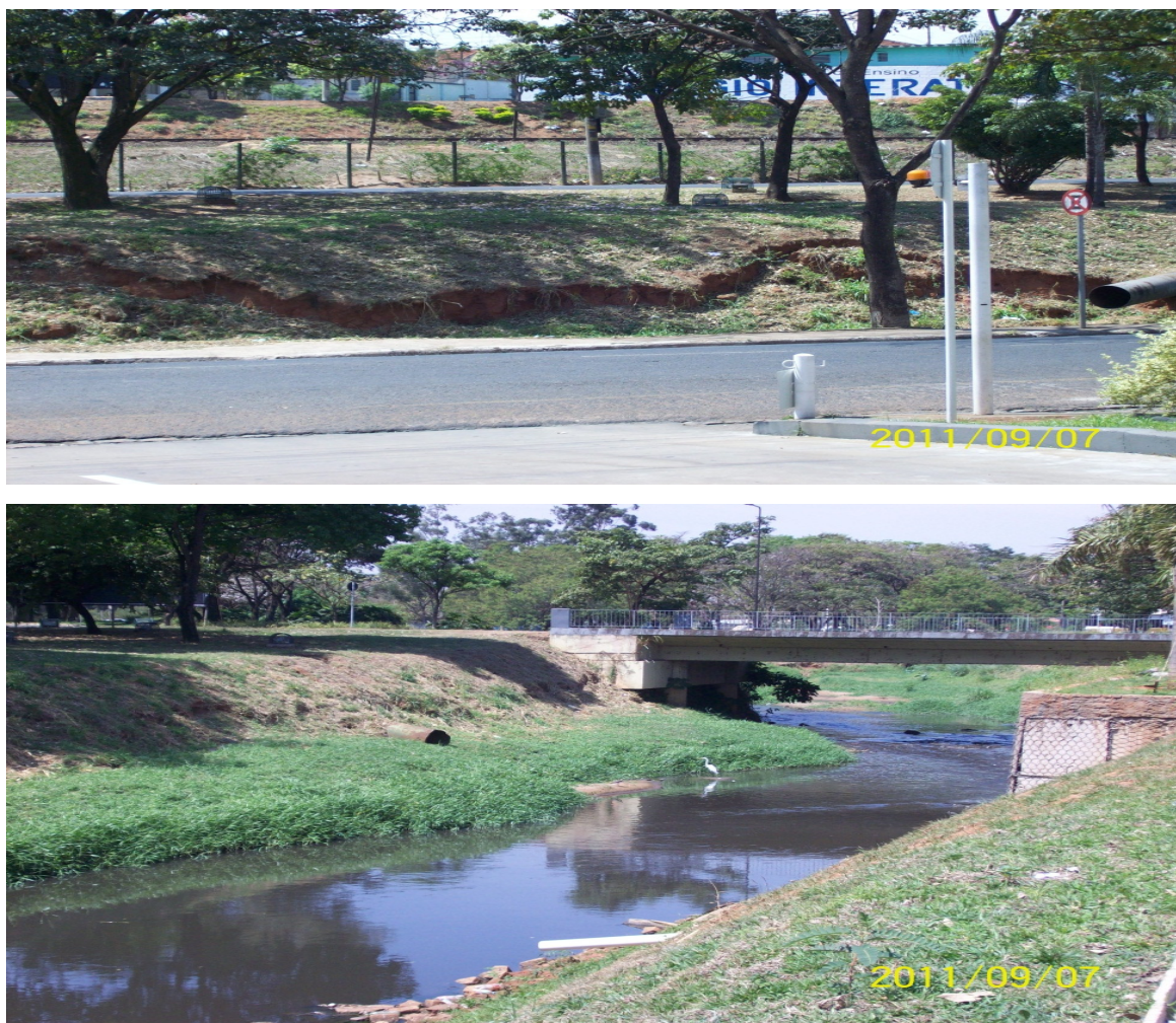
FIGURA 6 Vista de áreas marginais do Rio São Domingos na área urbana da cidade de Catanduva com problemas de erosão e assoreamento
