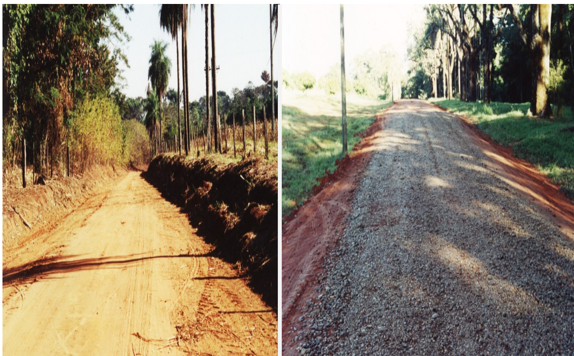
FIGURA 3 Leito de estrada rural antes e depois da recuperação, em Santa Adélia Fonte: Acervo do Pólo Regional Centro Norte.
