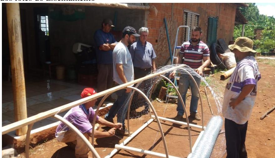
Figura 42 - Mutirão para construção do galinheiro móvel em um dos lotes do assentamento
