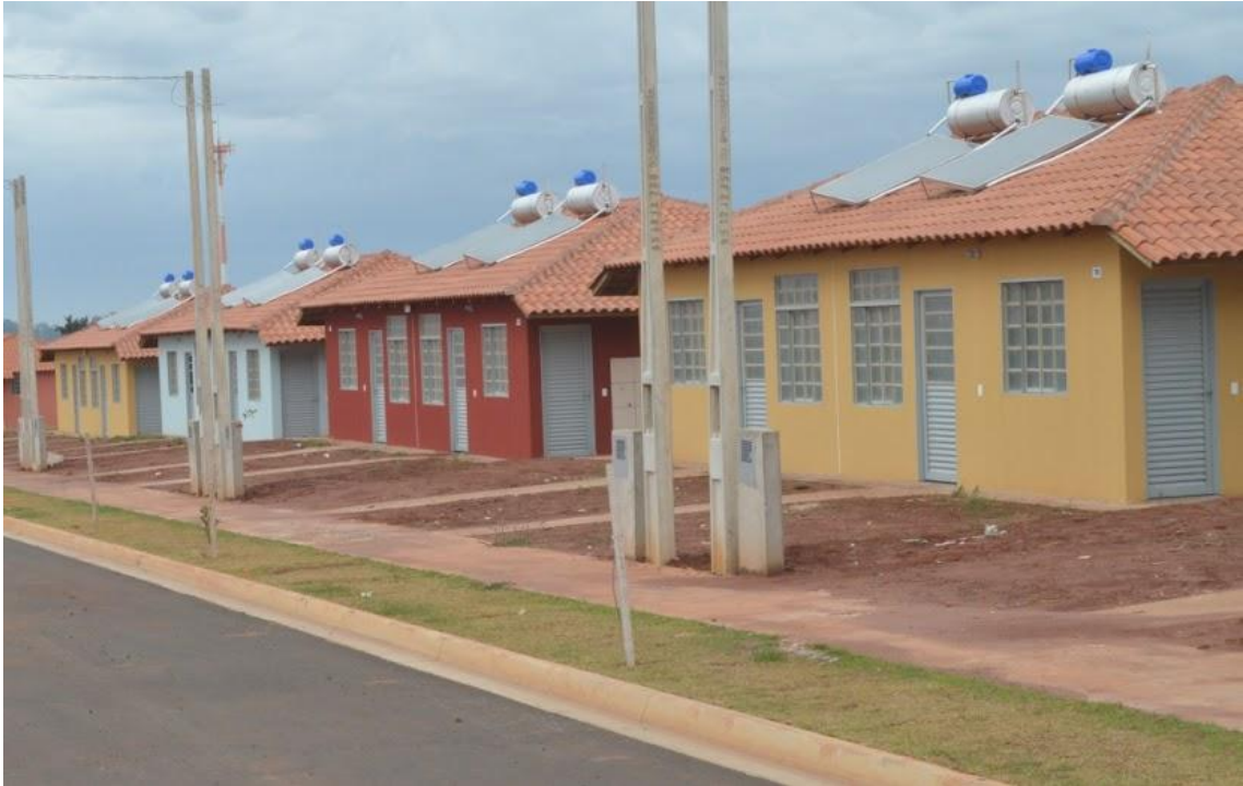
Figura 7 - Foto de uma das ruas em fase obras finalizadas para entrega.
