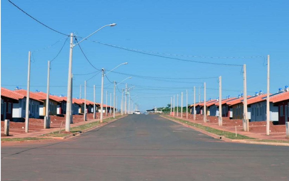
Figura 9 - Jardim do Valle: vista de uma das ruas do bairro na fase final da obra.
