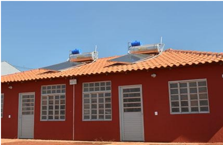
Figura 8 - Jardim do Valle: obra concluída.
