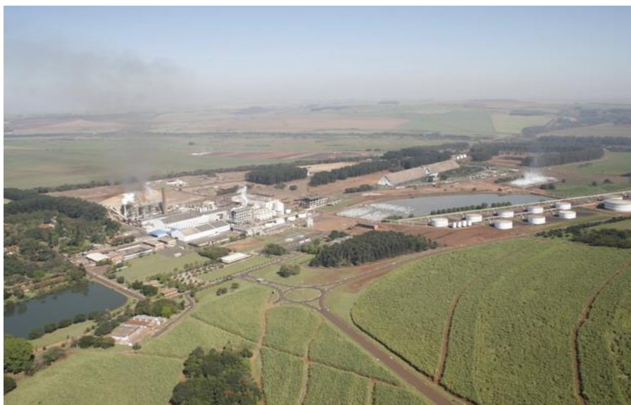
Figura 7: Vista panorâmica das atuais instalações da usina São Martinho
