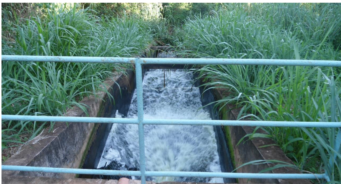
Figura 7 – Ponto de lançamento da Estação de Tratamento de Esgoto III
