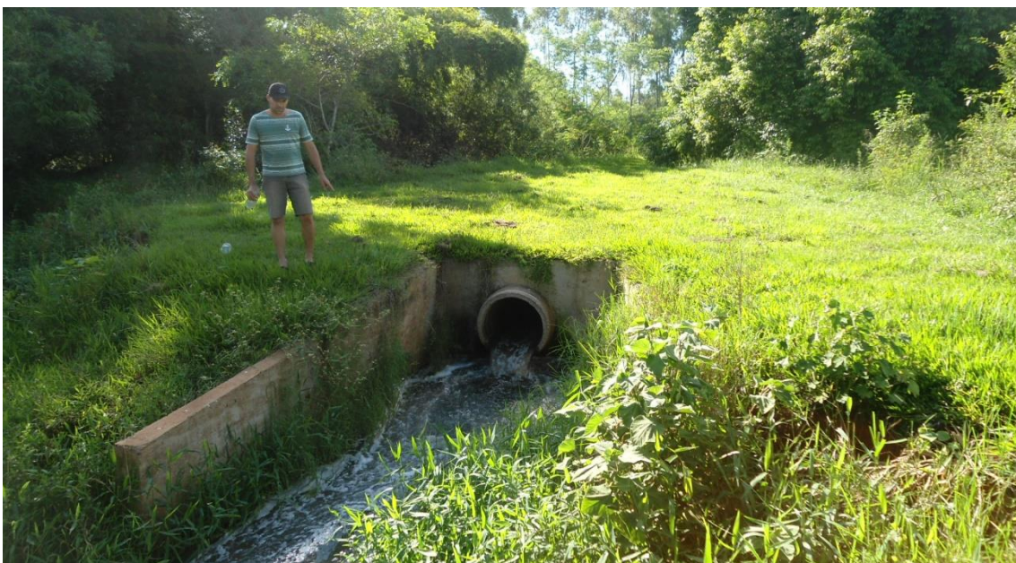
Figura 5 – Ponto de lançamento da Estação de Tratamento de Esgoto IV
