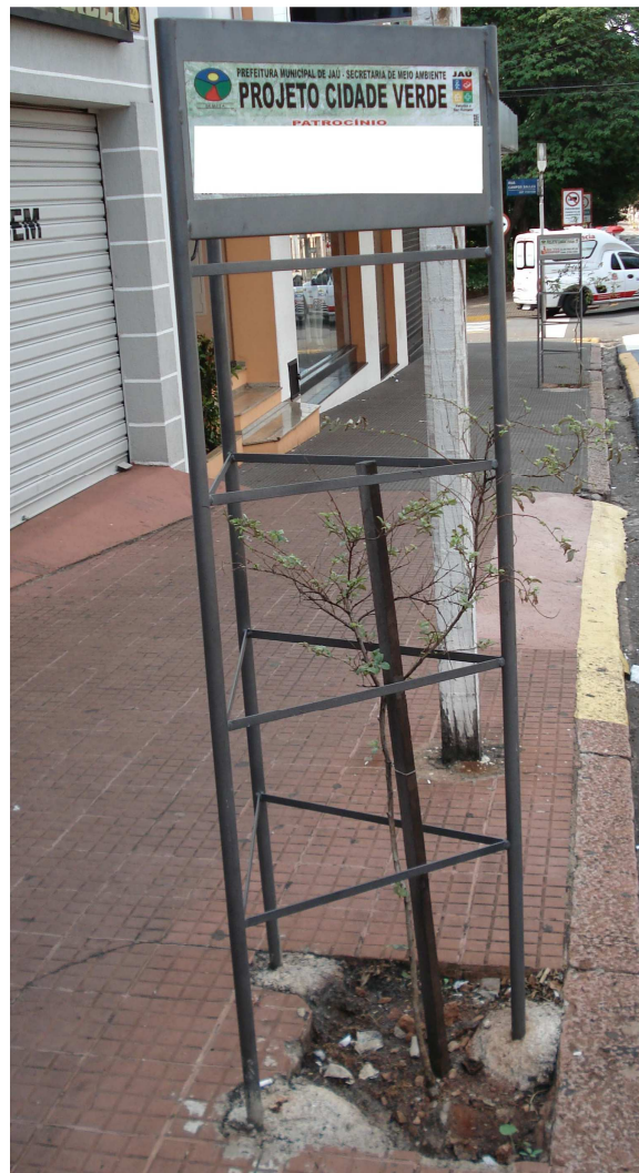
Figura 3. Modelo de grade de proteção utilizada no projeto “Cidade Verde”, Jahu, SP, 2009. Fotografia: Ana Luiza de Almeida Prado Capps
