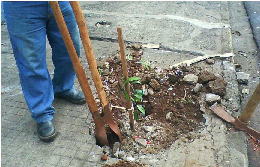
Figura 4. Abertura da cova para plantio de muda. Projeto “Cidade Verde”, Jahu, SP, 2008. Fotografia: Ana Luiza de Almeida Prado Capps
