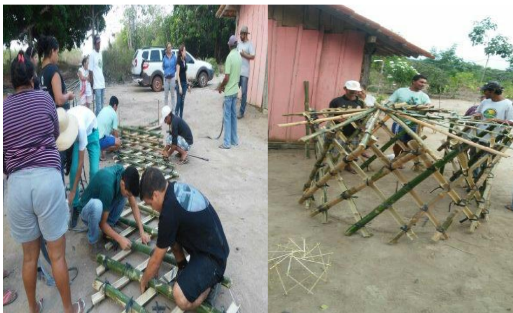
Figuras 3 e 4 - Construção do galinheiro móvel. Fonte: Núcleo de Agricultura Familiar e Agroecologia. 2015
