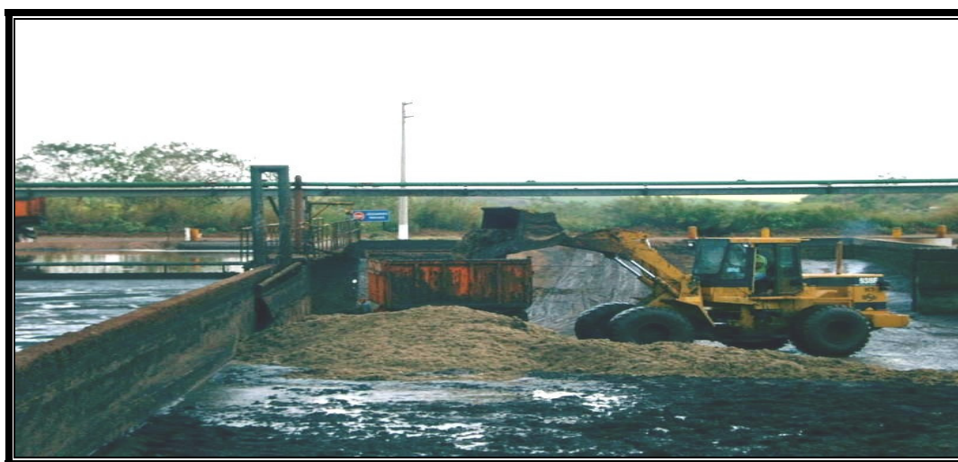
Figura 14 – Retirada de material da caixa de sedimentação
