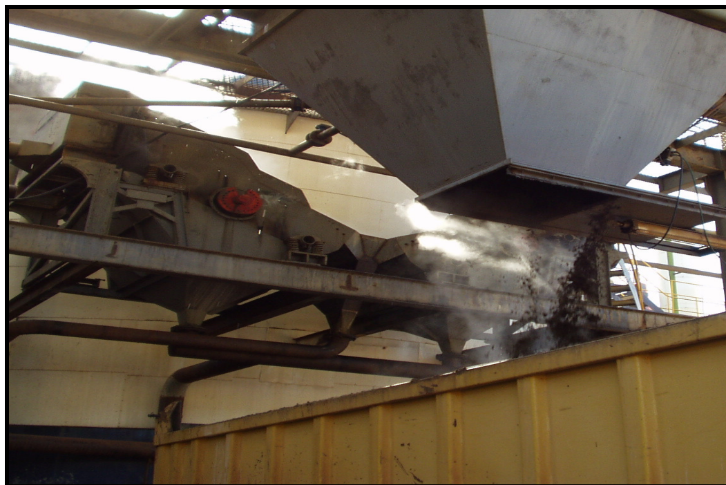
Figura 18 - Carregamento da torta em caminhão basculante
