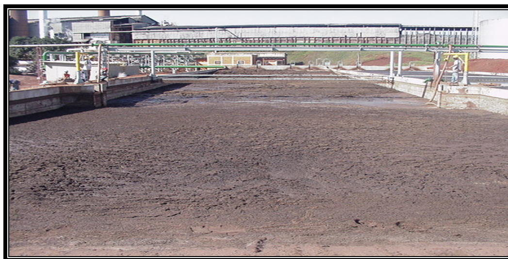
Figura 13 – Material sólido (impurezas) retido nas caixas de sedimentação
