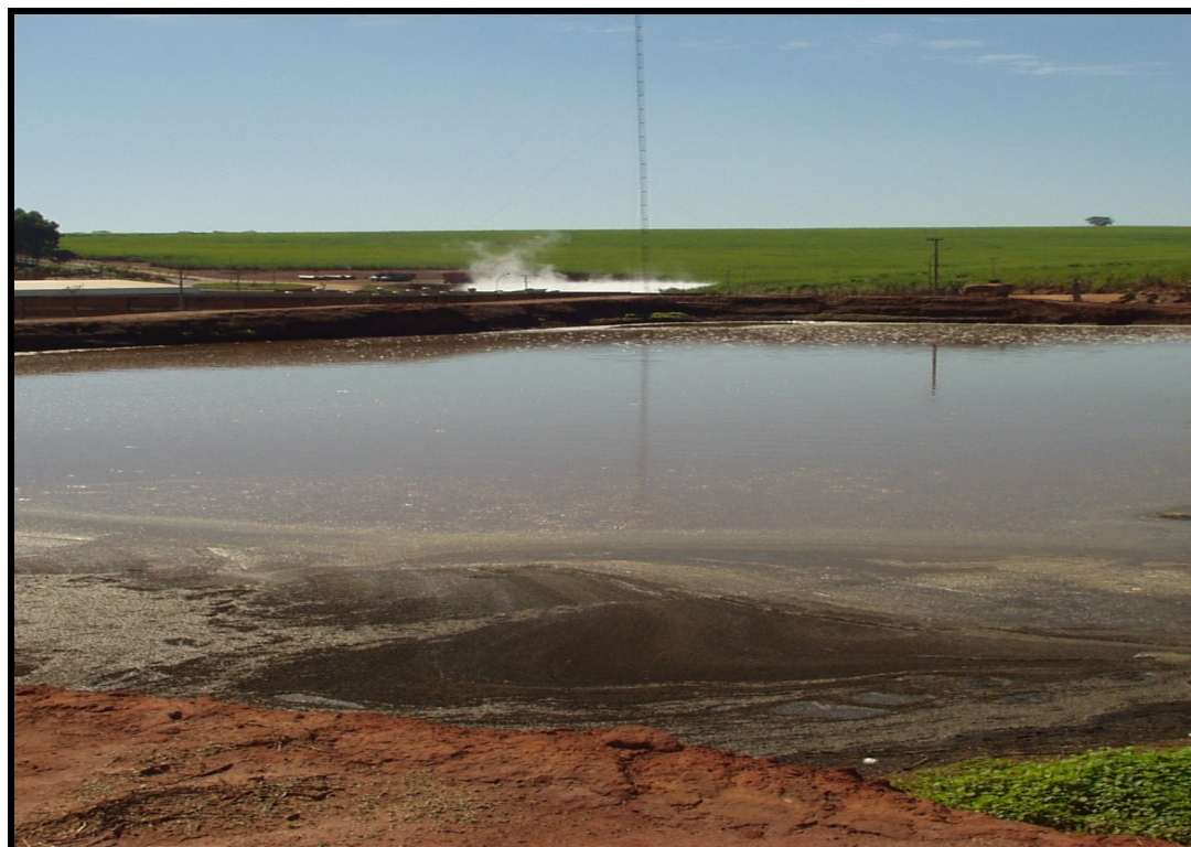
Figura 20 – Tanque de efluentes (vinhaça + água residuária)
