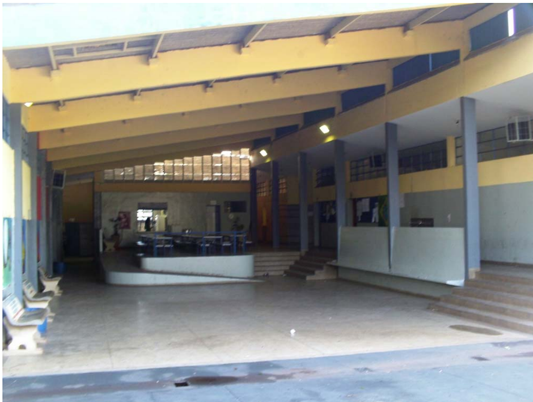
Figura 14 – Pátio Interno da “EE Capitão Joel Miranda”
